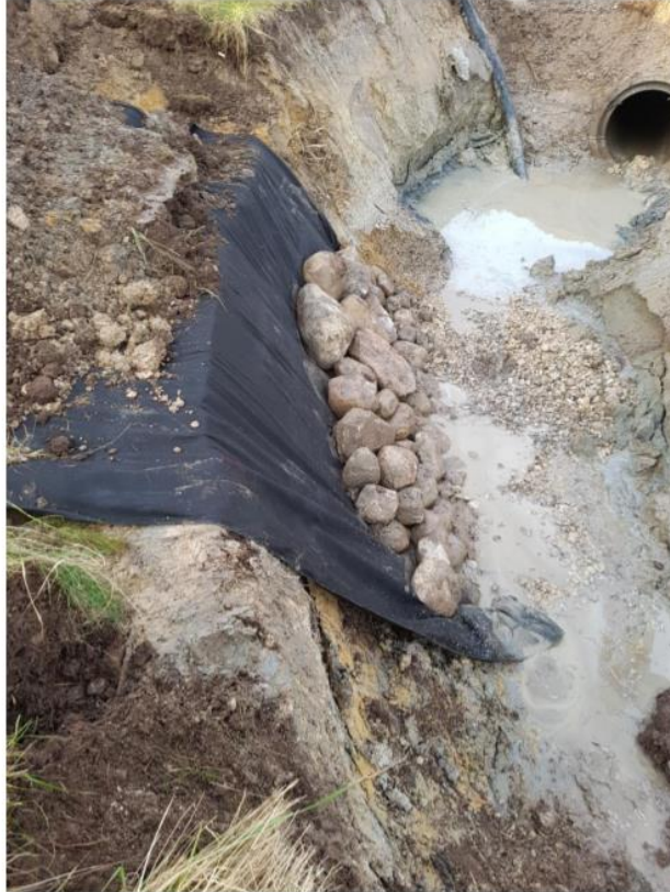
Billede af brinksikring med geotekstil.
