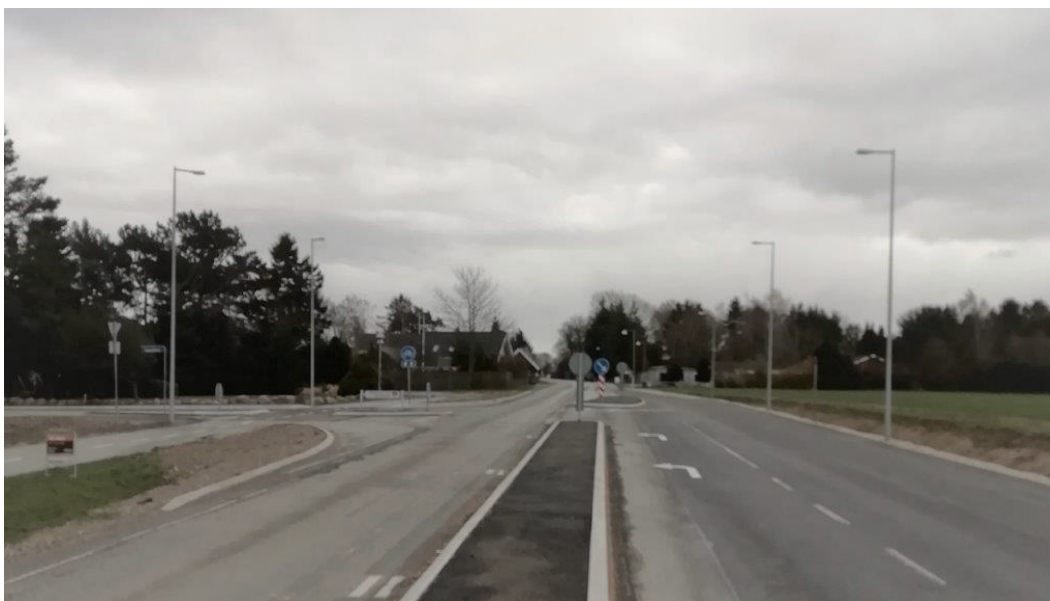
Kanaliserings ved Valnøddevej i Strøby Egede
