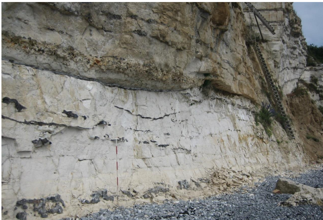
Figur 70. En massiv bænk af knoldeflint ligger ved foden af klinten i det indre Harvig. Ovenover er skrivekridtet gennemsat af pladeflint, hvilket gør skrivekridtet noget modstandsdygtigt. Stigen er en af de mulige, vanskelige nedgange til stranden. Bemærk det anastomoserende forløb af de subhorizontale sprækker.
