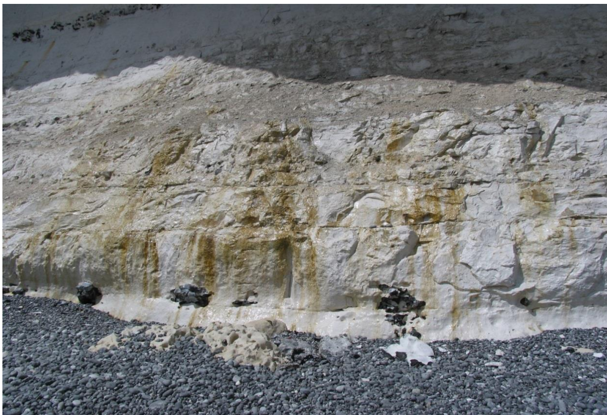
Figur 8. Klintafsnit i skrivekridt som er helt vådt af gennemstrømmende vand. Desuden er der udbredt gulbrun farvning af udfældede jernforbindelser. Vandudtrædelsen sker gennem horisontale sprækker ved foden af klinten, hvor der kan være forbindelse til grundvandspejlet (Foto: Merete Binderup).
