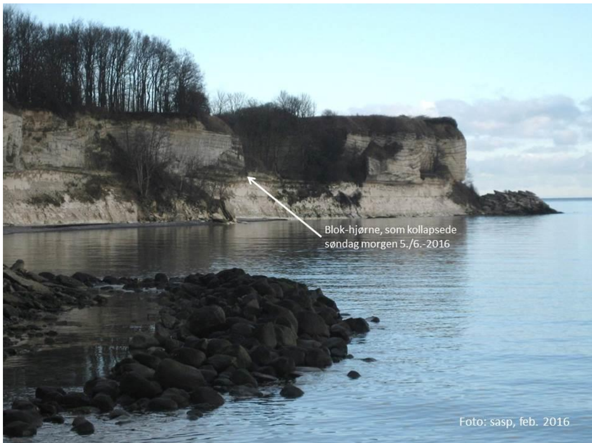
Figur 16. Udsigten fra foden af skrænten ved Højerup Gl. Kirke mod partiet ved Klintegård optaget ca. 4 måneder før det nye skred. Pilen angiver den blok som kollapsede ved fjeldskreddet søndag morgen 5./6.-2016. Det gamle skred ses som den bevoksede skråning umiddelbart til venstre for blok-fremspringet.
