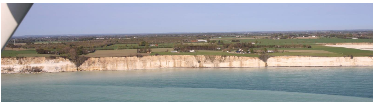
Figur 49. Flyfoto af området mellem Storedal og Lilledal optaget april 2011. Yderst til højre (mod nord) ses et hjørne af Sigerslev kridtgrav. Det karakteristiske ved denne del af klinten er den op mod 15 m tykke lagserie af kvartære aflejringer, som er årsagen til jordfarvningen af klinten.
