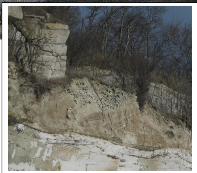
Figur 34. Overjordsdynger med fyldmateriale i det gamle kalkbrud ved Højeruplund giver anledning til bekymring, da løse sten og blokke konstant falder ned fra disse. På fotoet herover ses, hvordan fyldet ligger i dynger i bunden af det langstrakte kalkbrud. Til højre et nærbillede af en jorddyngede med tydelig skrålejring fra opfyldet. Der må advares mod stenras fra disse dynger.
