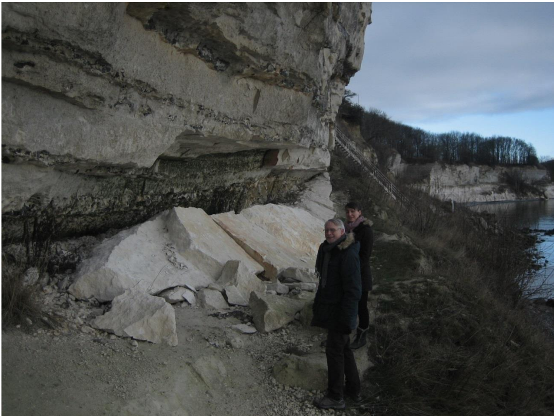
Figur 22. Pladefaldet ved Klintekongens Hule. På billedet ses den 16,5 m lange og op til 4 m brede plade, der har mistet kontakten med den overliggende bryozokalk og faldet ned fra undersiden af overhænget. Faldhøjden vurderet til ca. 2 m, og den samlede vægt af pladen omkring 65 tons. Hvis en person havde befundet sig under overhænget og fået pladen ned over sig, ville vedkommende næppe være overlevet. Bemærk den lodrette exfoliationsretning på klippen oven for flagefaldet.
