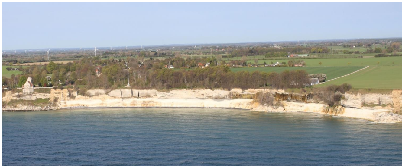
Figur 13. Flyfoto optaget april 2011, som viser det gamle skred ved Klintegård og den blok ved siden af, som nu er faldet ned. Både nord og syd for fjeldskreddet ved Klintegård findes gamle kalkbrud. Bemærk rustfarvningen af klippen, som skyldes vandgennemsvivning i opsprækket kalk.
