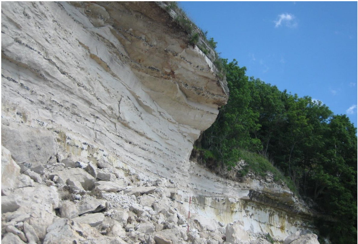
Figur 17. Det tilbagestående udhæng oven over brudplanet for Klintegårdsskreddet. Skala-inddelingen på landmålerstokken er 20 cm. Bemærk striberne efter udsivende grundvand. Fotoet er taget mod NØ, d.9./6.–2016.
